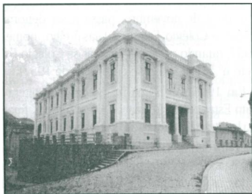
Figura 1 – Prédio Saldanha Marinho
